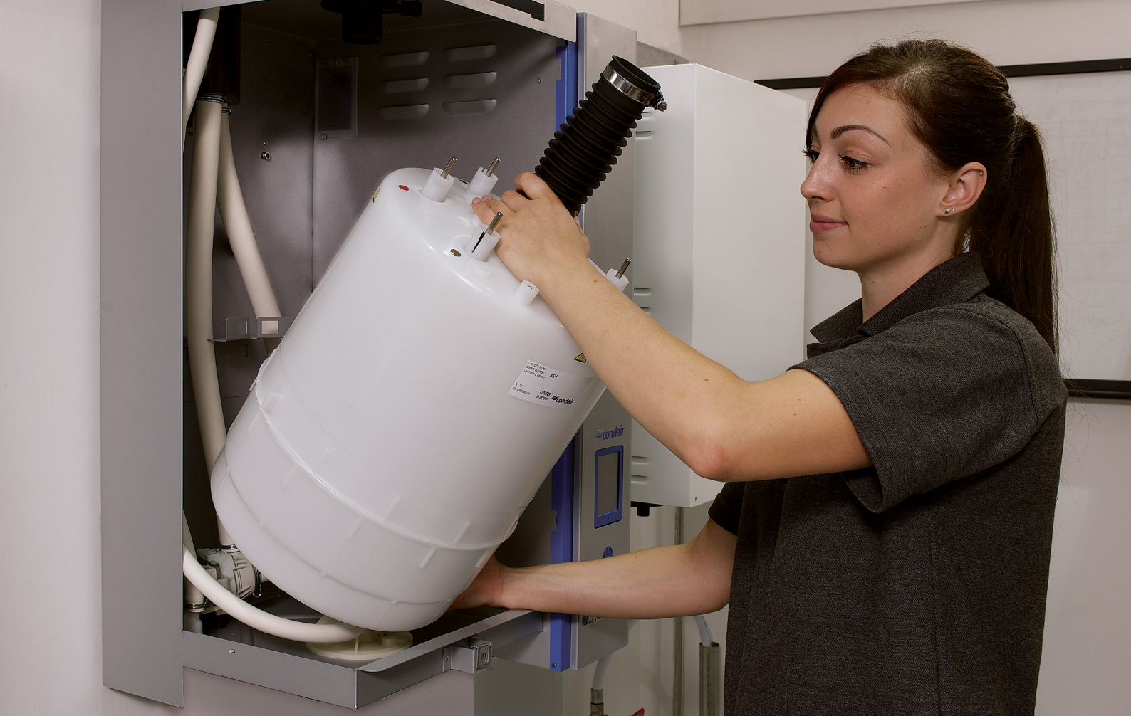
Değiştirilebilir buhar silindirleri, hızlı ve basit bakım ve minimal duruş süresi sağlar.
